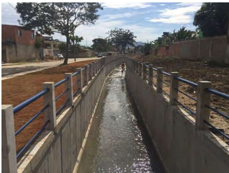
Foto37: Rio Papagaio pós-canalização, 2015, em Inhoaíba
