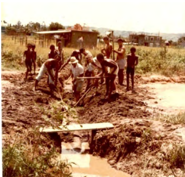
Foto11: Mutirão para fazer esgoto, 1982
