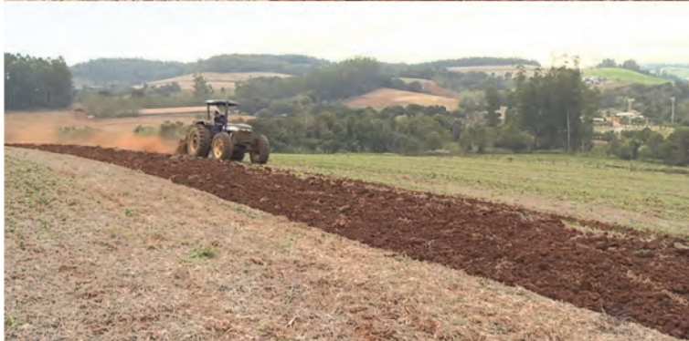
Figura 8.11 – Construção de terraço comum com arado de disco pelo método da ilha - Fonte: extraído de EPAGRI (2023).
