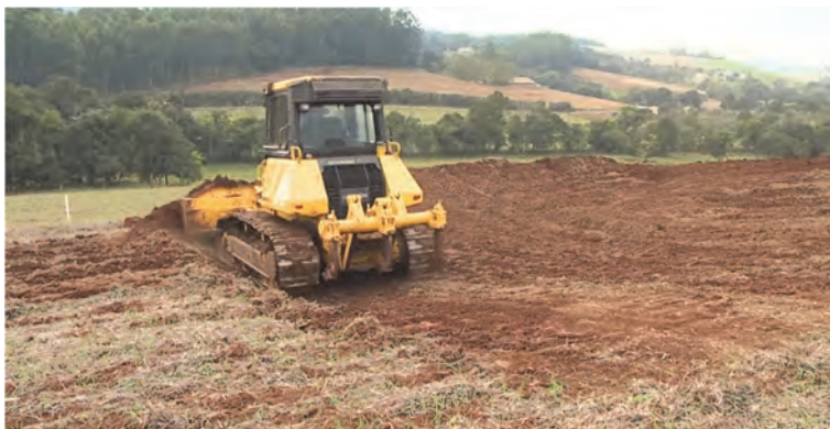
Figura 8.10 – Construção de terraço comum de base larga, com lâmina frontal Fonte: extraído de EPAGRI (2023).
